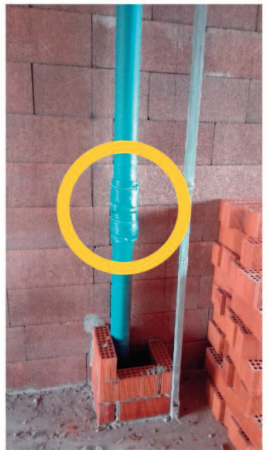
Unione tra i due isolanti acustici SONIK, fondamentale per il giusto isolamento, il nastro SONIK fissato con due fascette.
